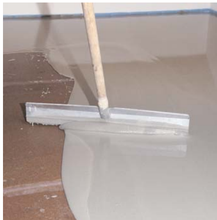
Derefter fordeles PCI Nanosilent med en rakel i den ønskede lagtykkelse.
