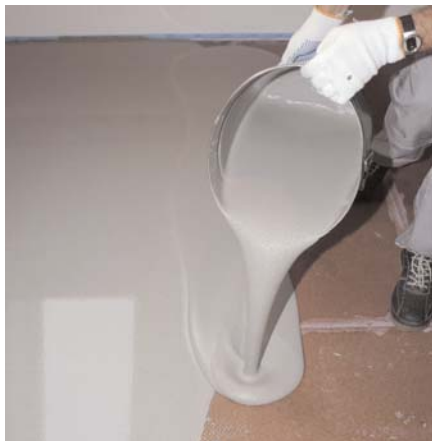
PCI Nanosilent hældes ud på underlaget.
