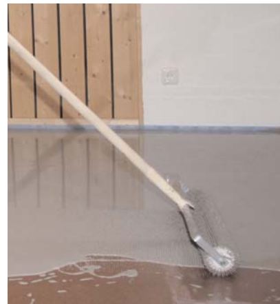
PCI Nanosilent afluftes med en pigrulle.
